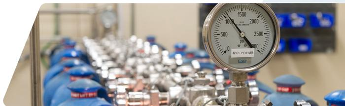
**RED DE SUMINISTRO:** Las redes de suministro pueden ser en acero inoxidable electro pulido o en cobre 304L según la calidad del gas a transportar.
